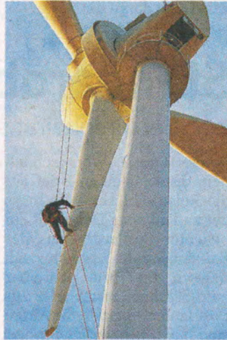
Ein Arbeiter eines Windradherstellers ist in 50 Meter Höhe mit der Reparatur eines Flügels beschäftigt. Foto: dpa
